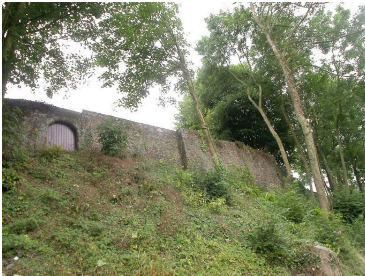
Mur nord du prebytère
