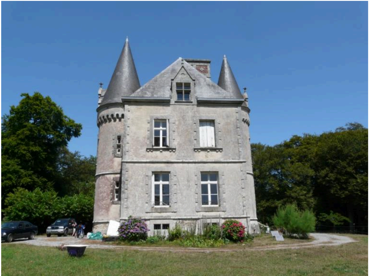
Mur pignon ouest
