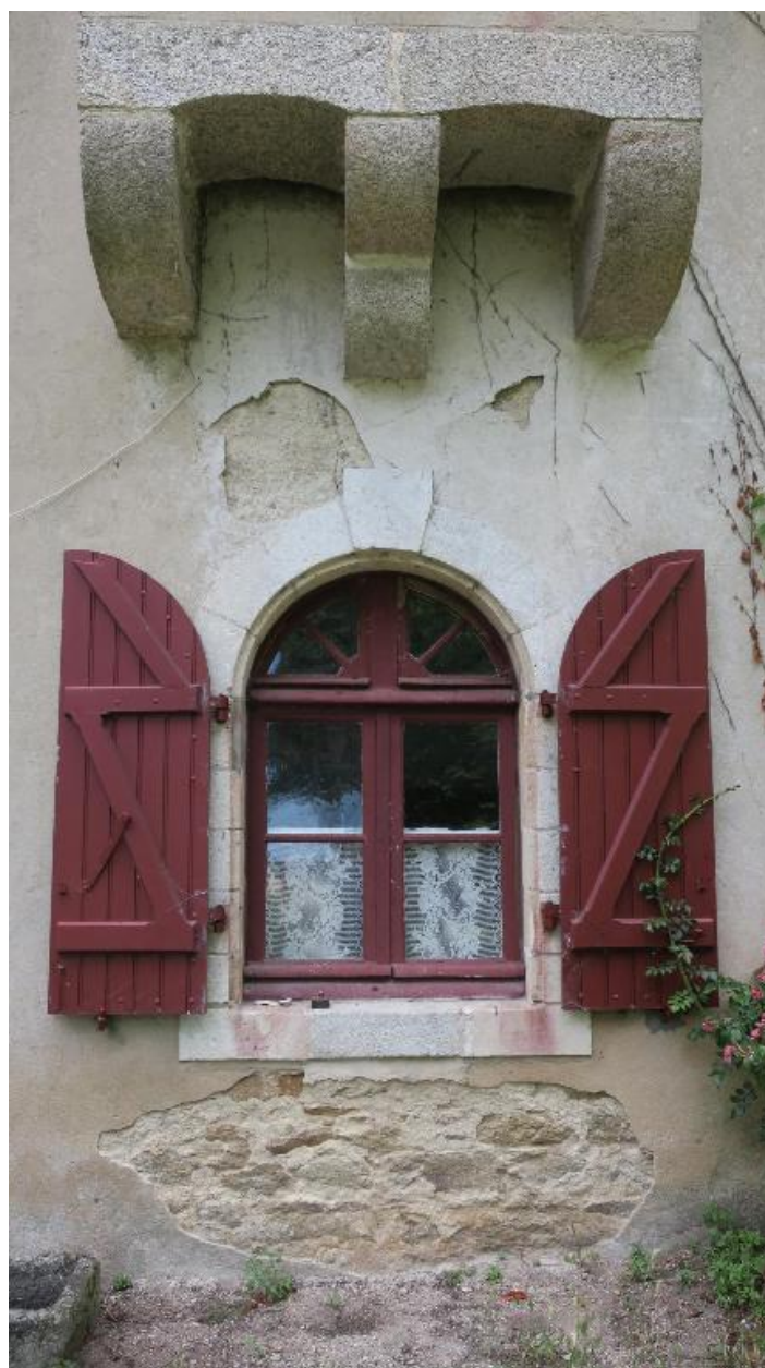
Saint-Pierre-Quiberon, batterie de Beg Quilvi, corps de garde crénelé, baie agrandie et consoles de bretèche.
