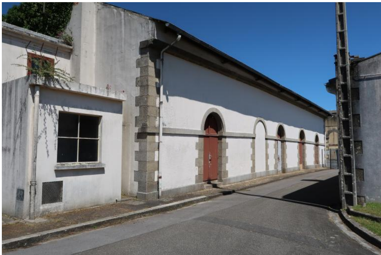
Vue générale : élévation sud (état en 2022)
