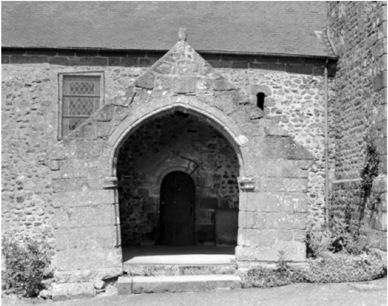
Elévation sud, porche : vue générale
