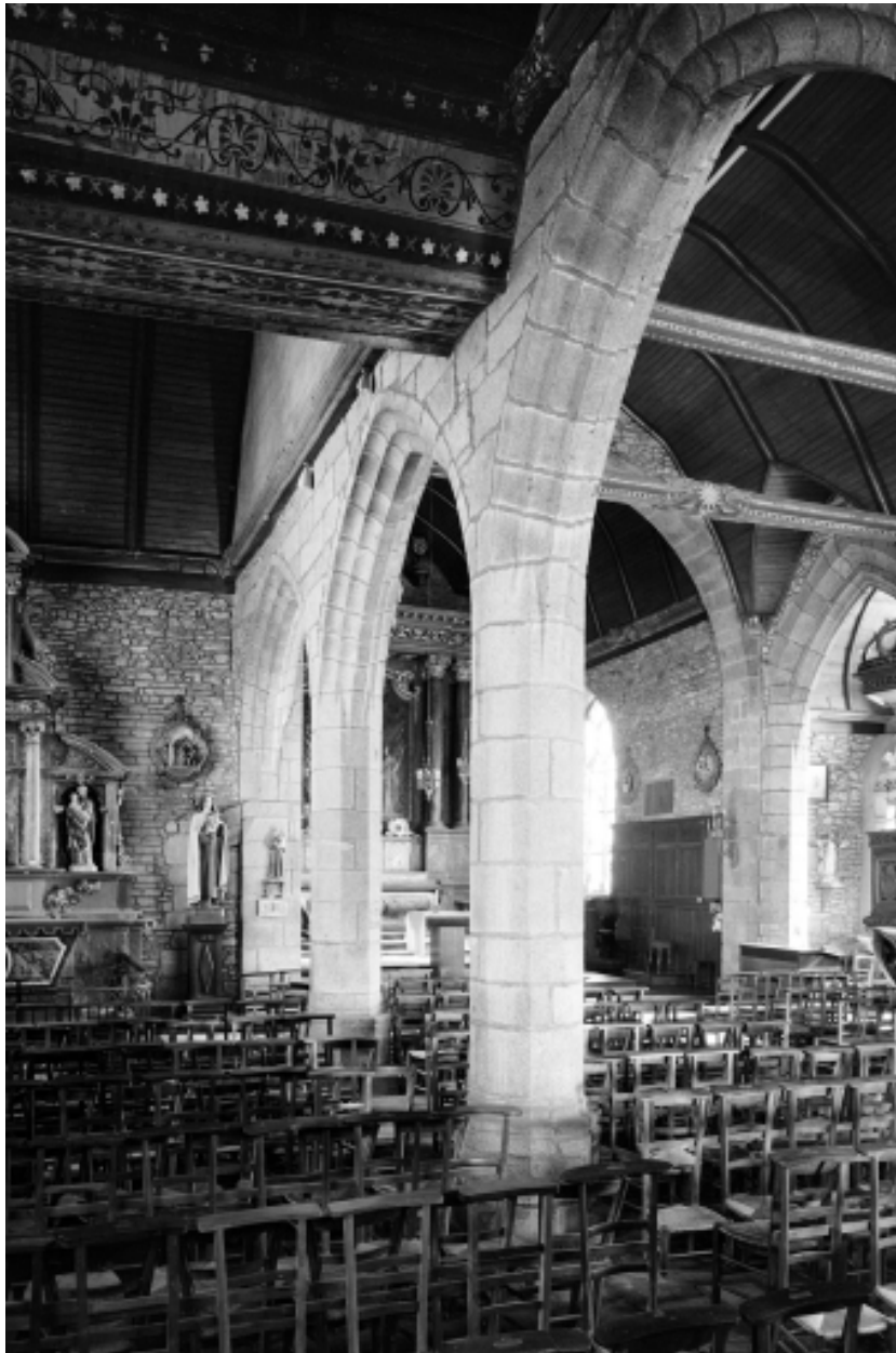
Intérieur, bas-côté nord, vue prise du nord-ouest.
