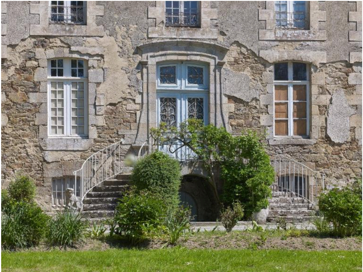
Escalier en fer à cheval de la façade ouest
