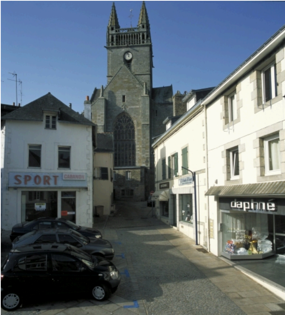
Elévation est, vue générale
