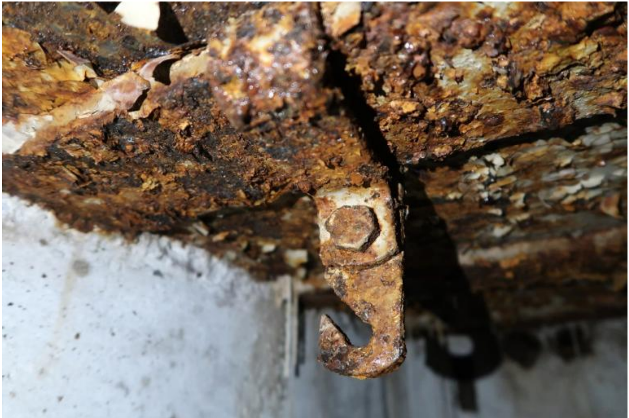
Vue intérieure : salle de garde sud, détail d'un crochet de suspension pour couchettes tubulaires
