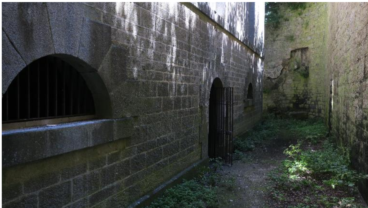
Hœdic, fort central, caserne à l'épreuve, bas du pignon sud.
