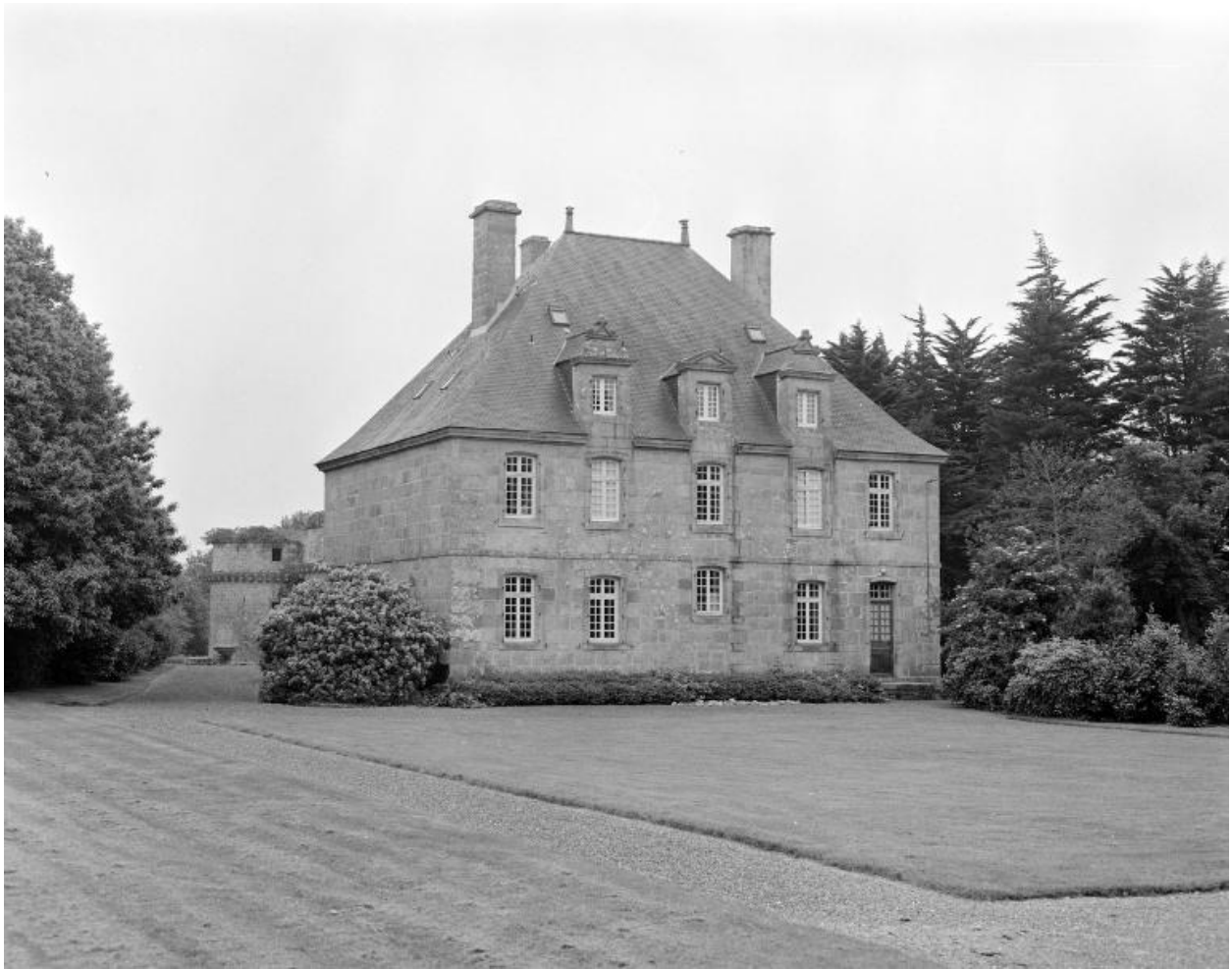
Vue de la demeure située au nord du château : élévation orientée vers le nord-ouest (état en 1986)
