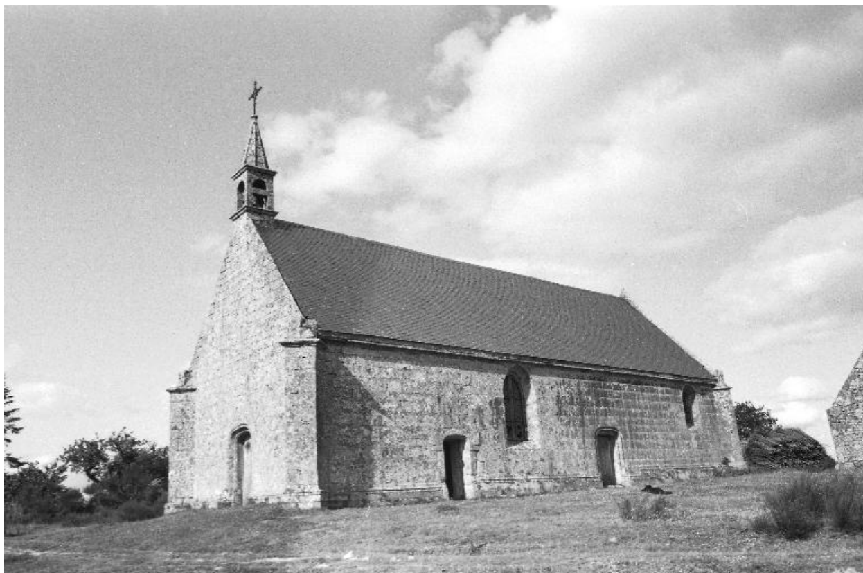
Vue générale prise du sud-ouest.
