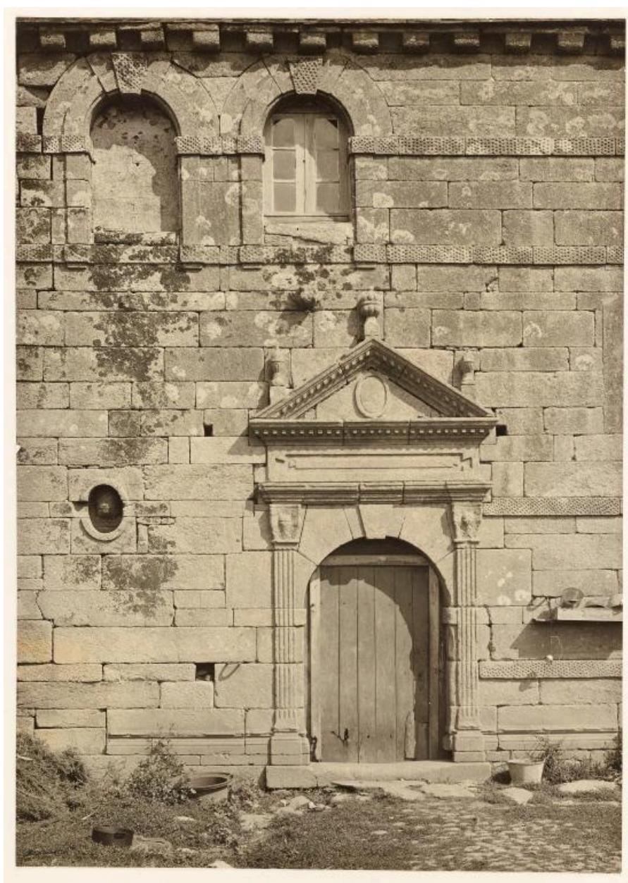
Emplacement d'origine à Plovan vers 1930. Elévation antérieure, détail de la porte d'entrée.
