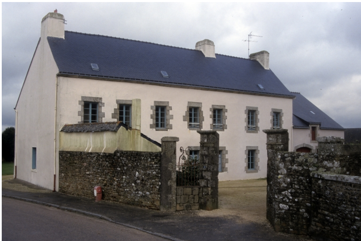
Elévation sud, vue générale.
