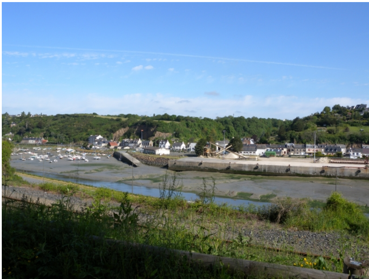
Vue du terre-plein de la Ville-Gilette avec les nouveaux quais
