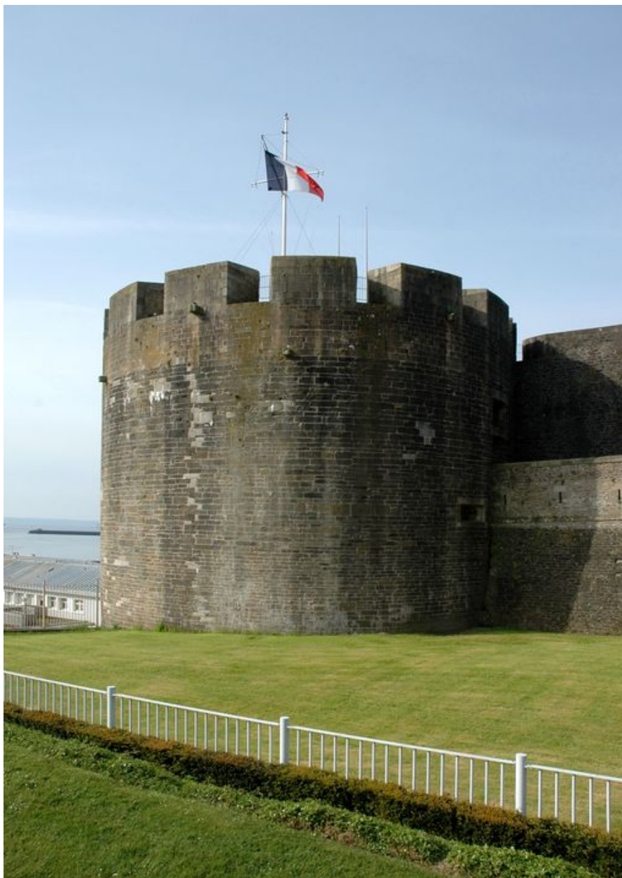
Vue de la tour de la Madeleine
