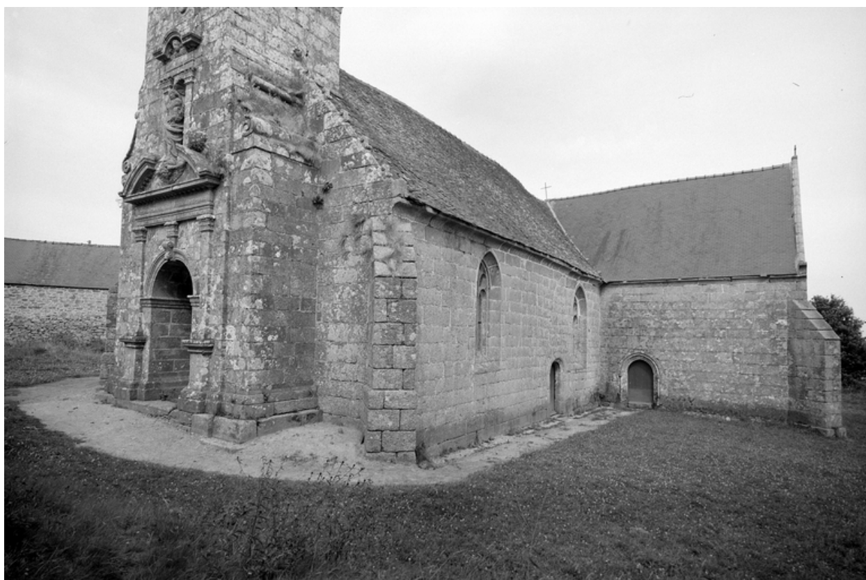
Façades ouest et sud : vue générale prise du sud ouest
