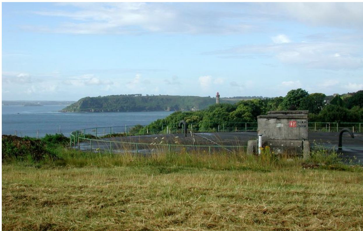
Vue du parc à carburant de Maison Blanche
