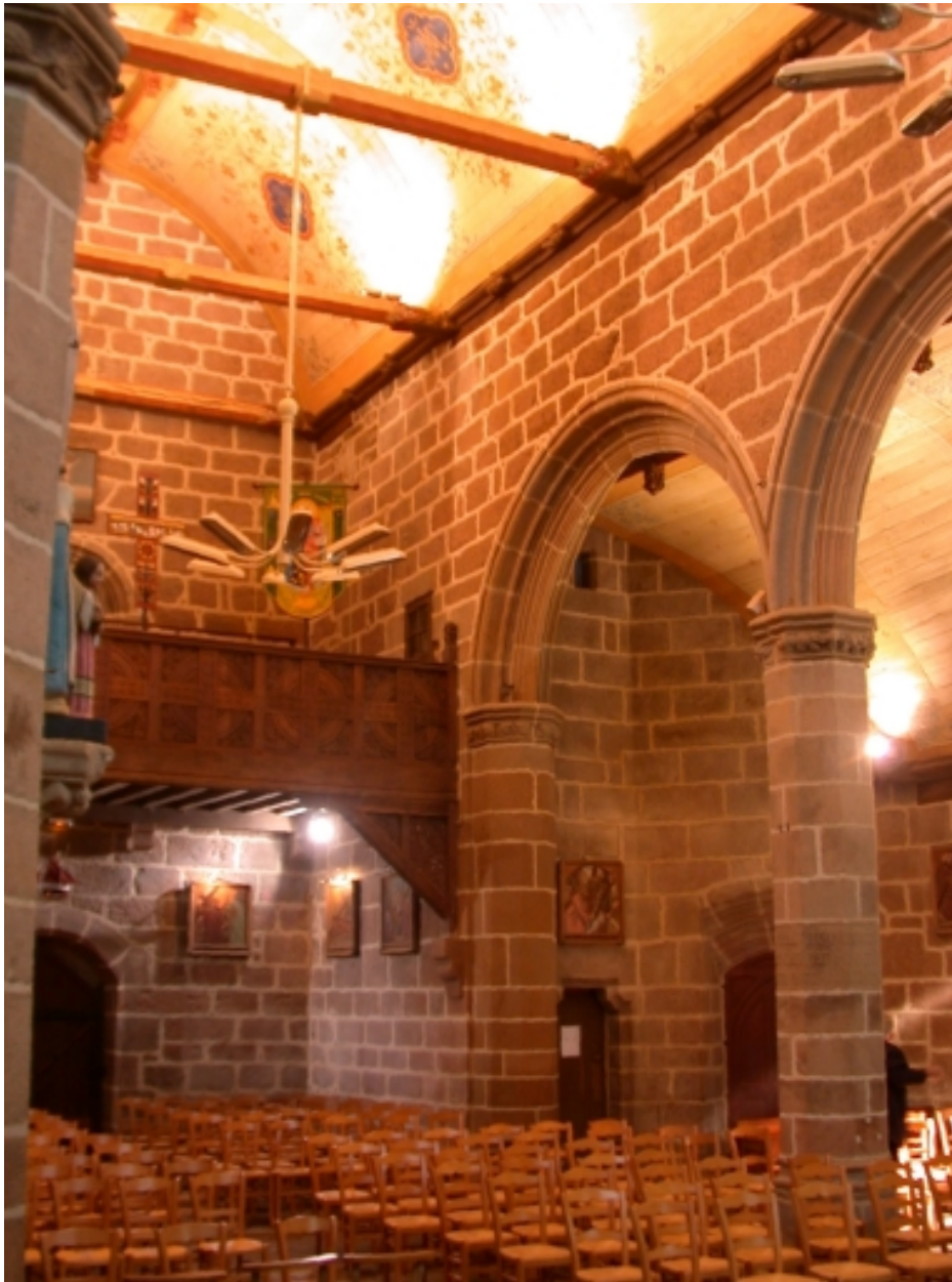
Espace intérieur : vue vers le bas de la nef et sa tribune
