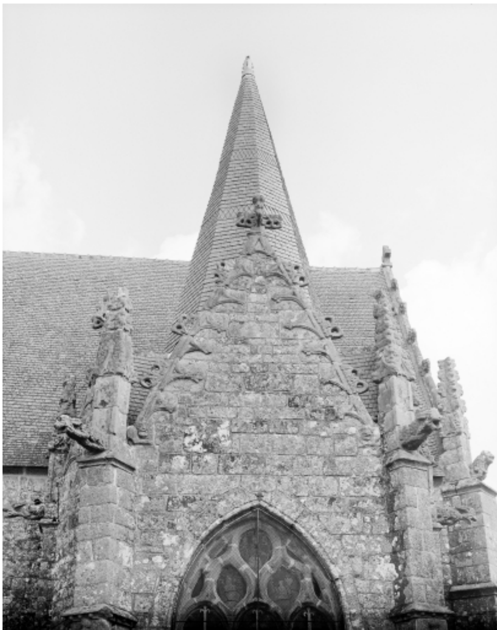
Elévation sud, chapelle saint-Yves : partie supérieure du pignon sud.
