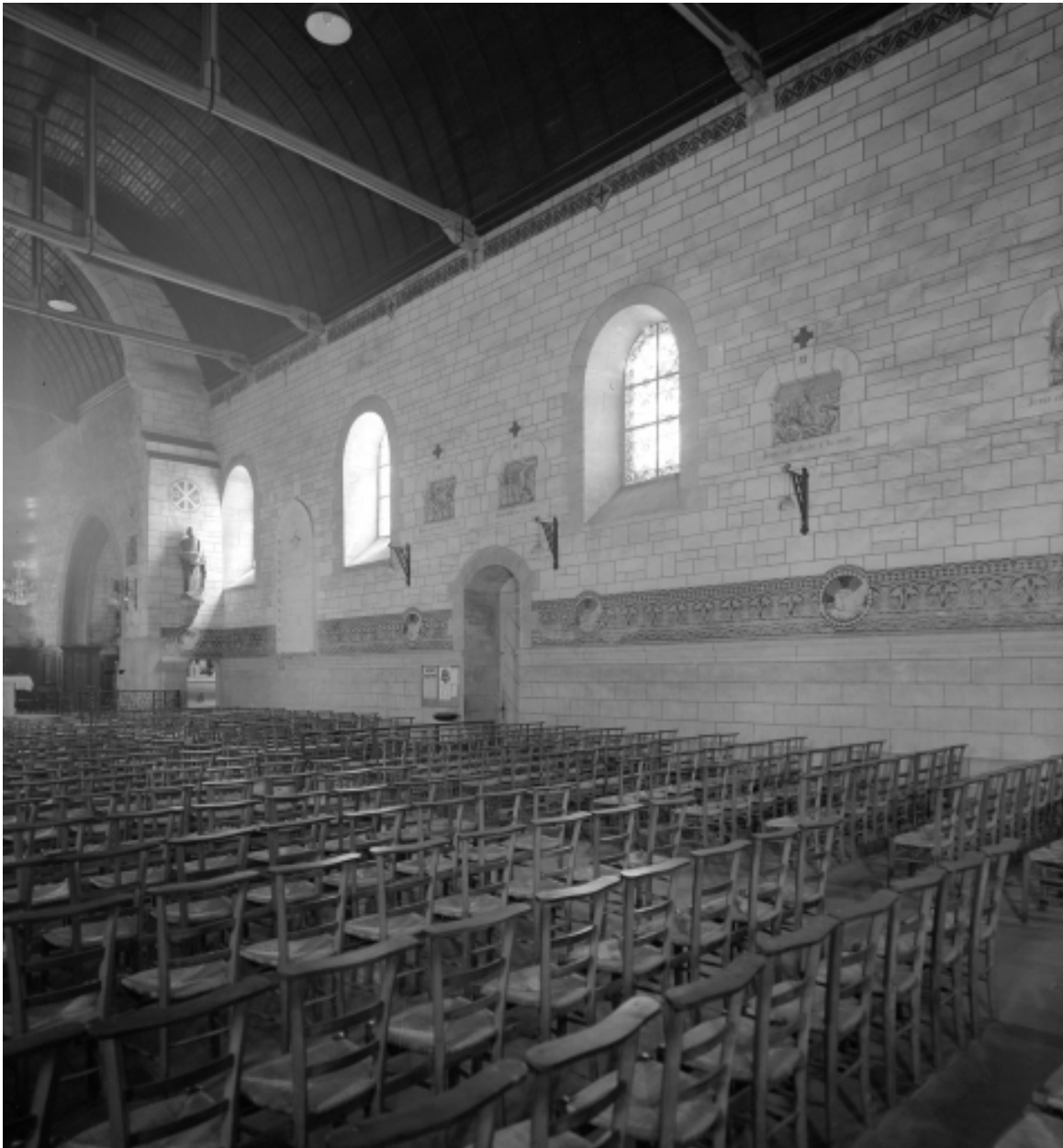
Intérieur, nef, mur sud : vue générale.
