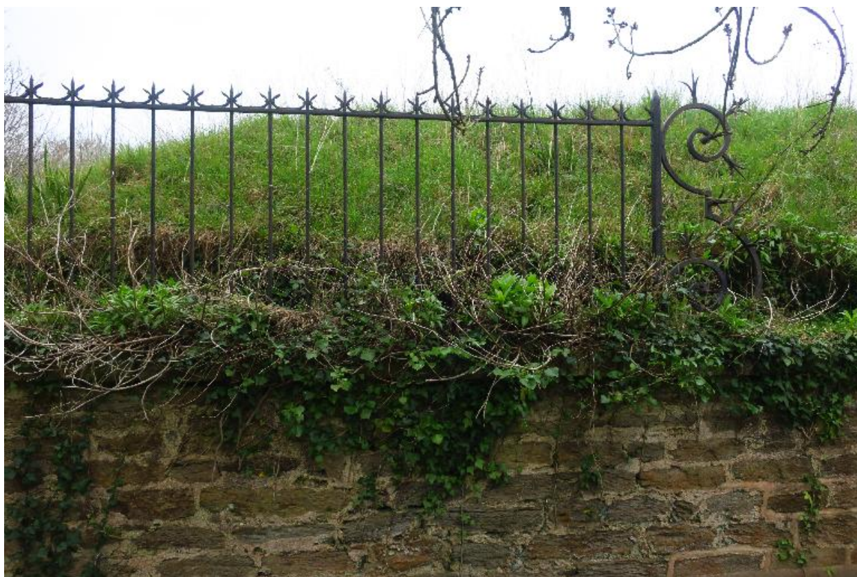
Le Palais, enceinte urbaine, bastion 20, grille défensive.
