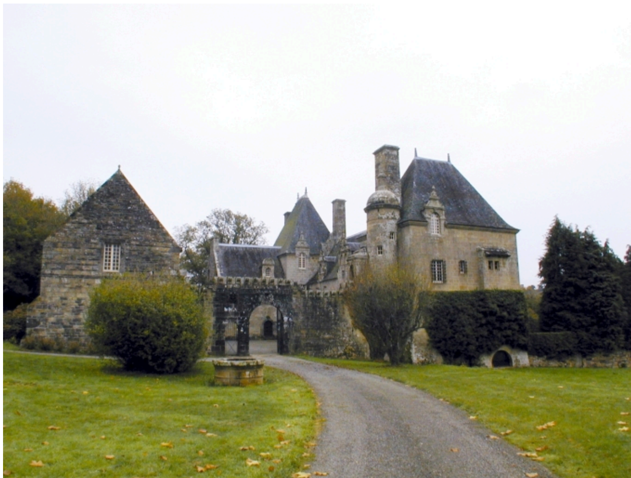
Vue générale depuis l'arrivée
