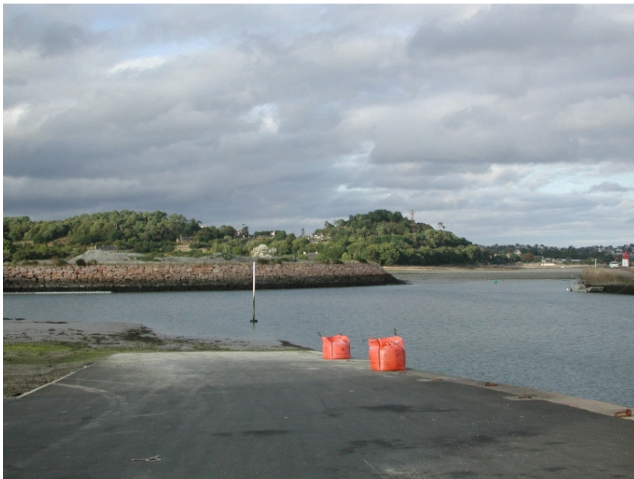
Vue du parement de la rampe d'accès à la grève
