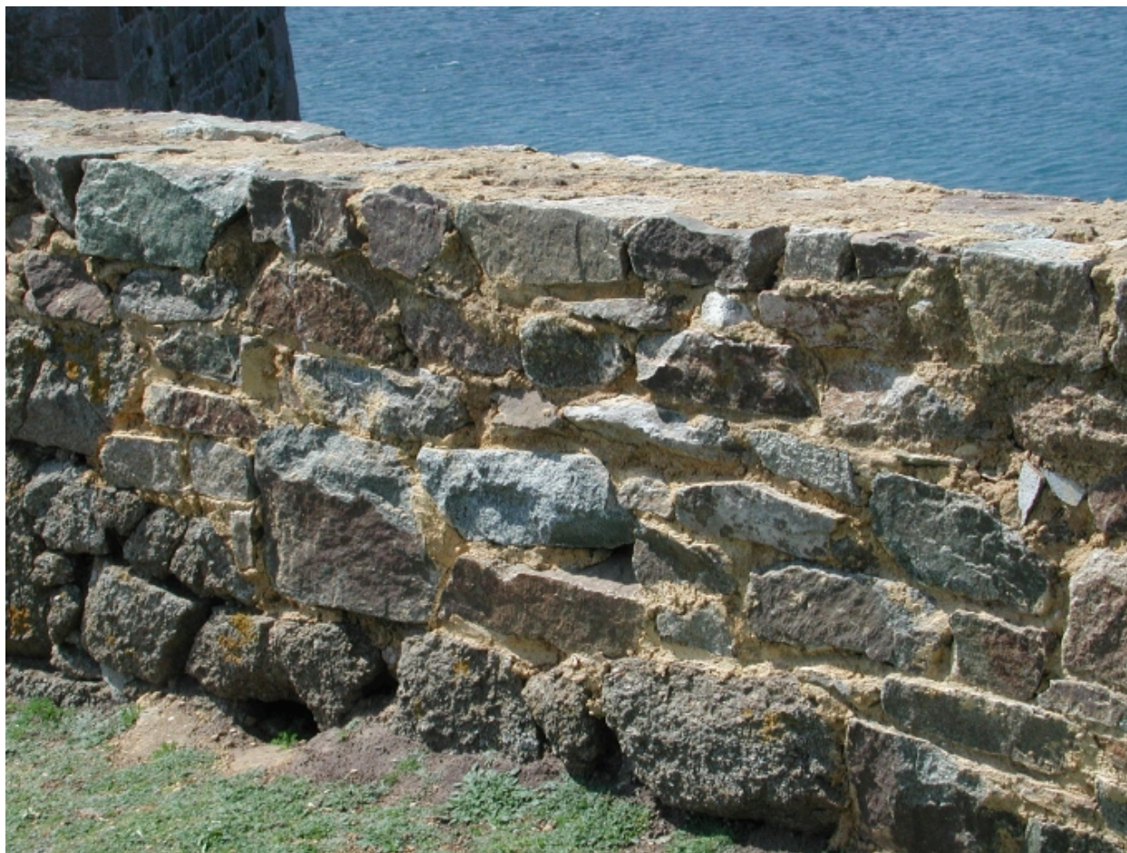
Vue en détail de la restauration traditionnelle des murets défensifs
