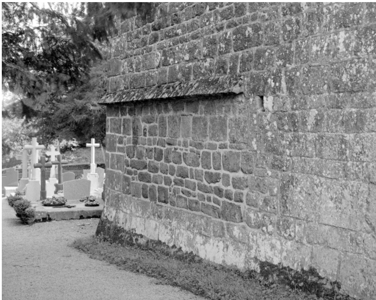
Elévation nord : détail du mur.
