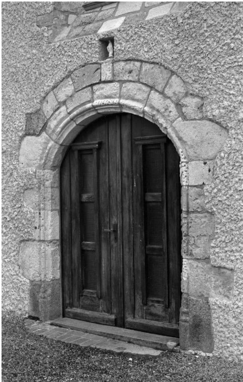
Eglise Saint-Melaine, entrée sud
