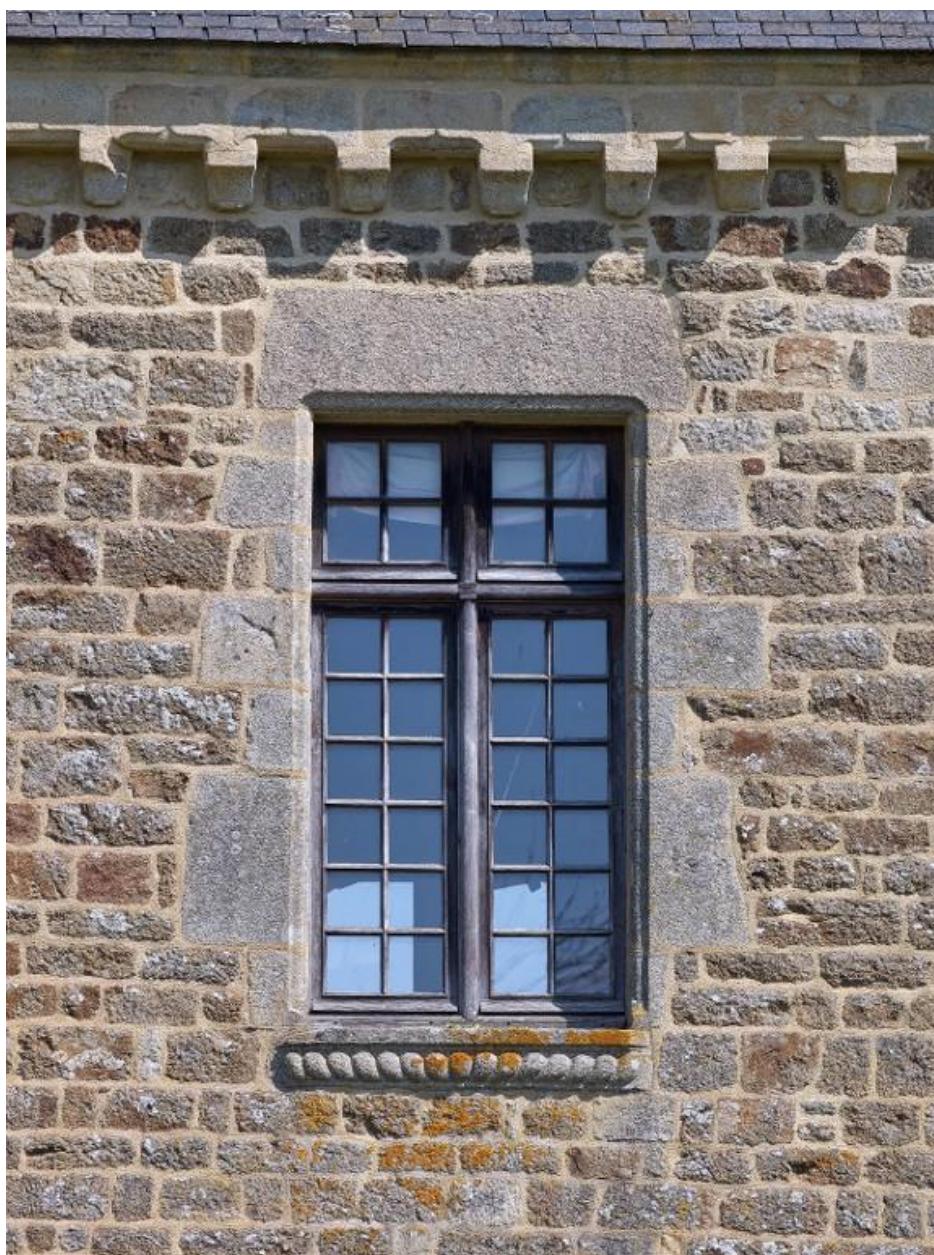
Baie, détail sculpté et corniche
