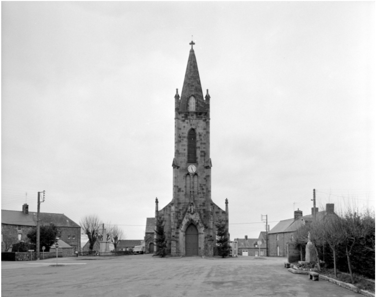
Elévation ouest : vue générale
