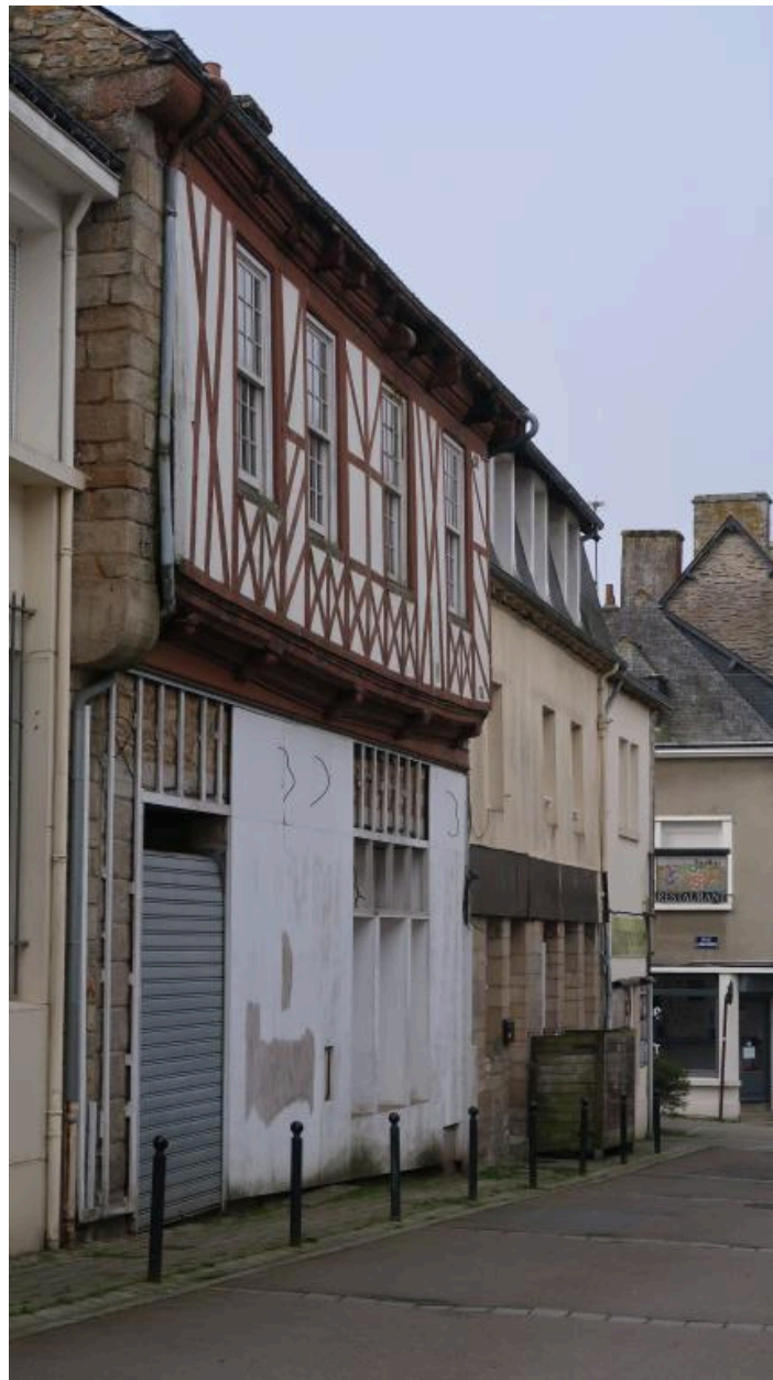
Façade du 12 rue Beaumanoir avec rdc en travaux (2019)
