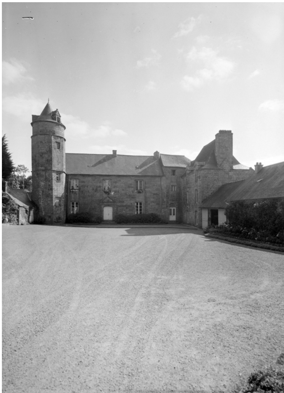
Façade nord : vue générale
