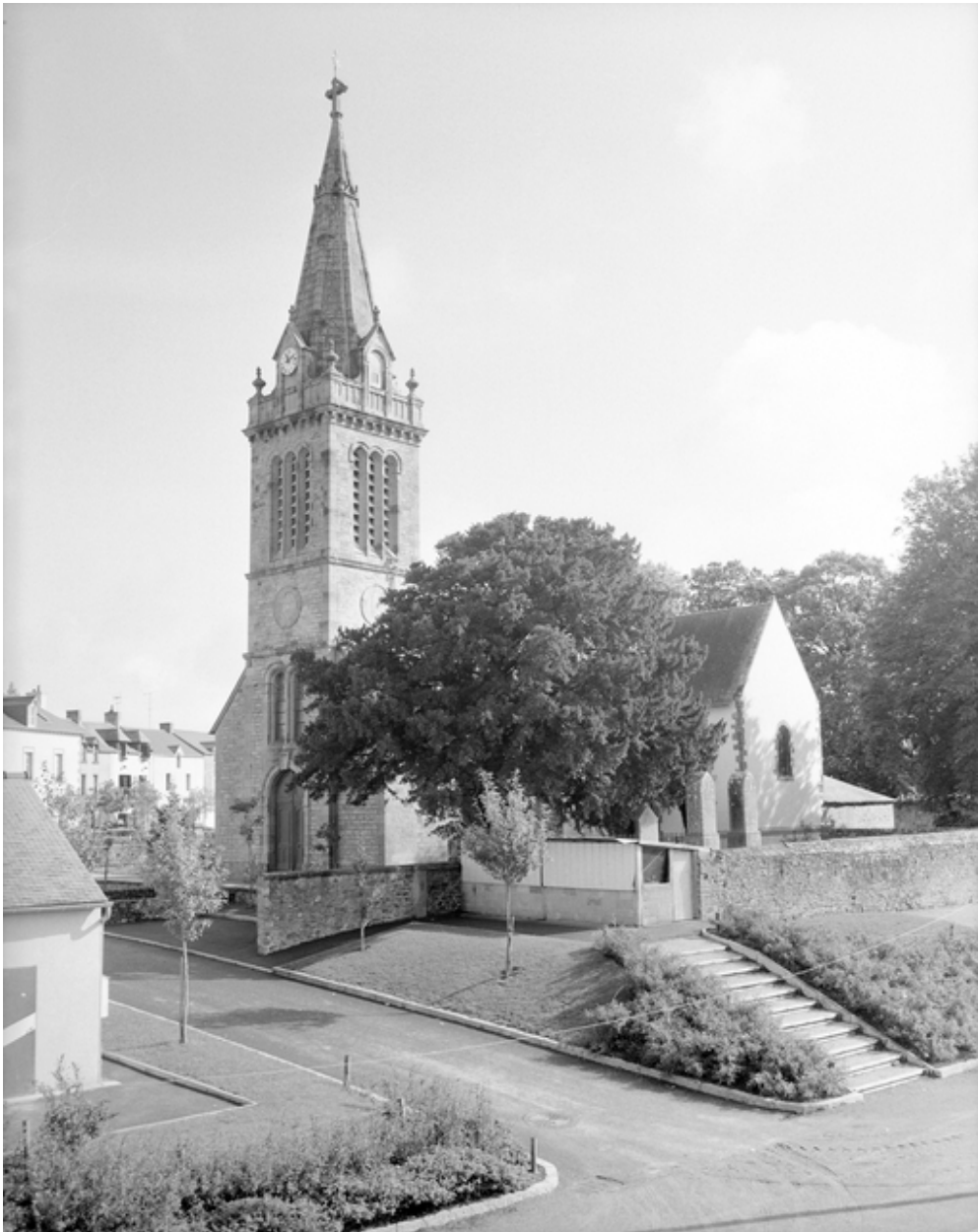
Elévation Sud-Ouest : vue générale
