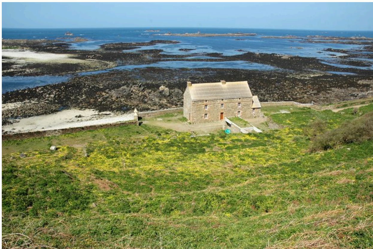
Vue de situation (état en 2006)
