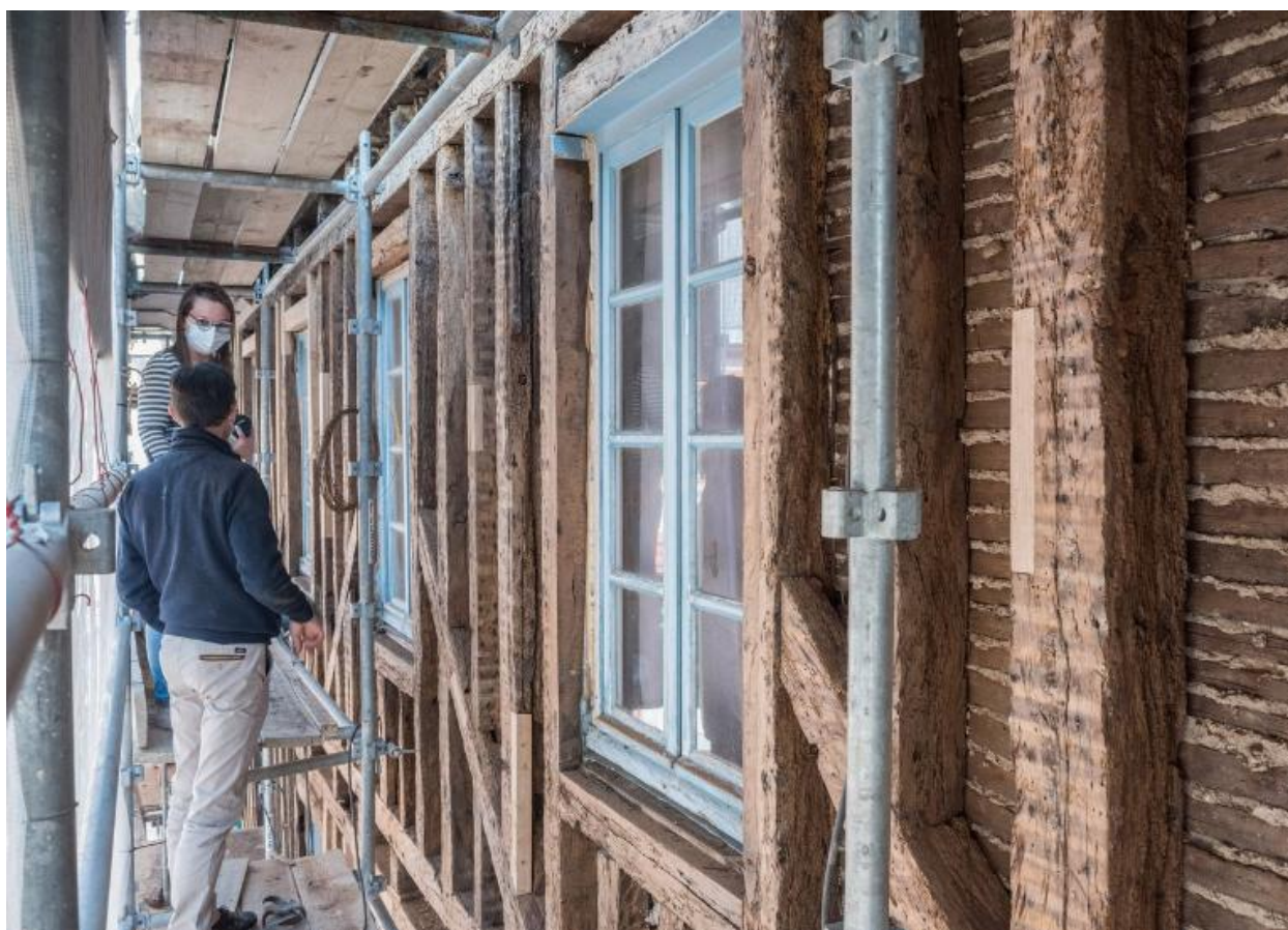
Premier étage, restauration de la façade sud-ouest.
