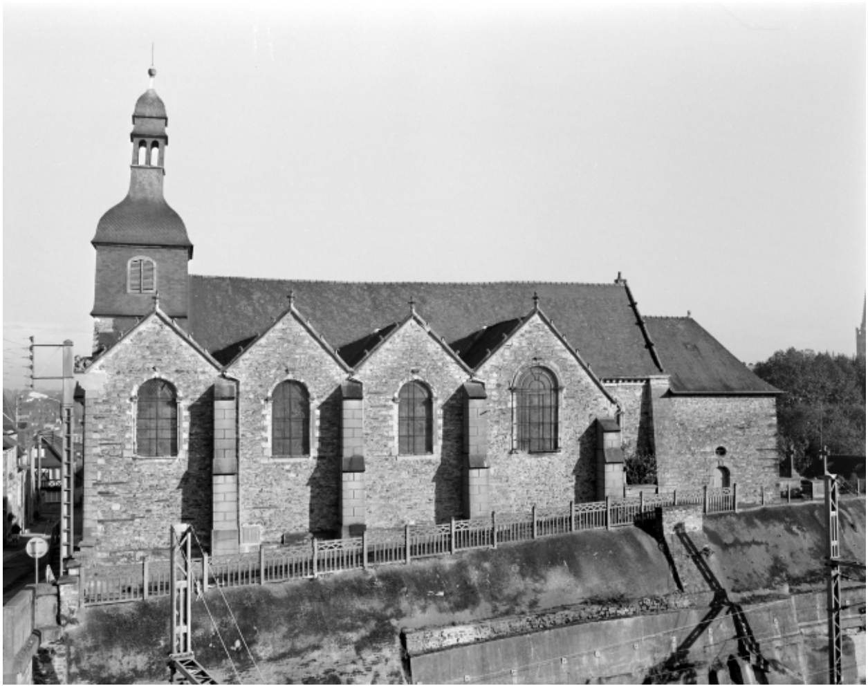
Elévation Sud : vue générale.
