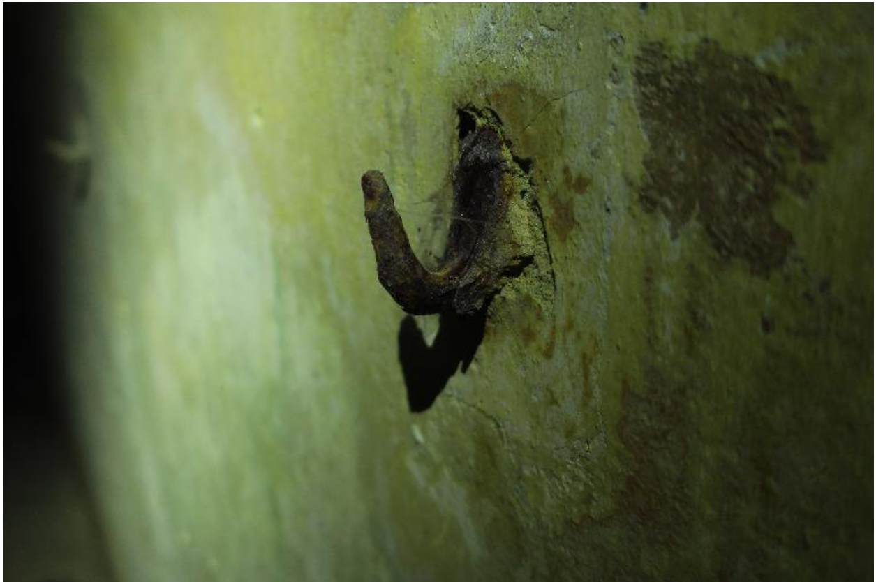
Locmaria, Grands Sables, batterie de La Ferrière, corps de garde crénelé, crochet de hamac.
