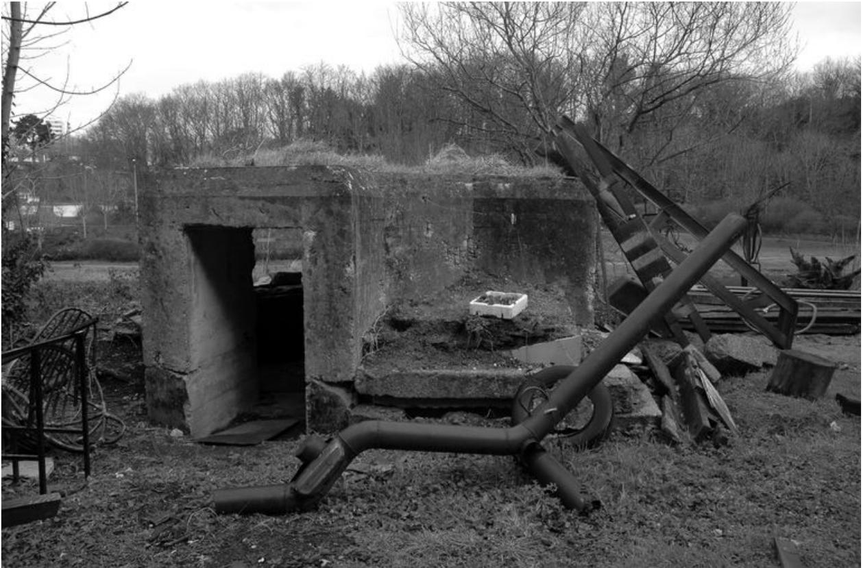
Vue de la cuve de type 1694 pour canon de 5 cm sous masque en béton armé de Kervallon. Ce bunker est situé à l'extrémité nord du quai
