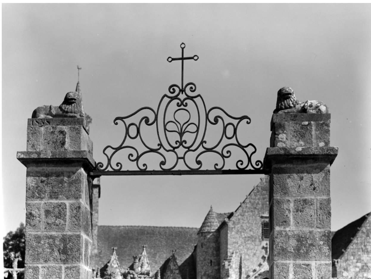
Vue de détail du portail d'entrée
