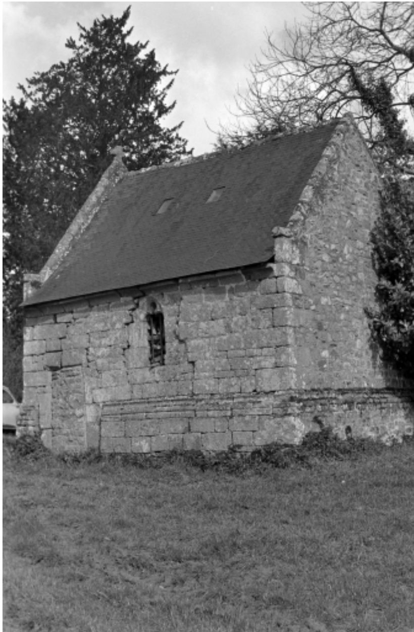
Chapelle : mur ouest et façade sud
