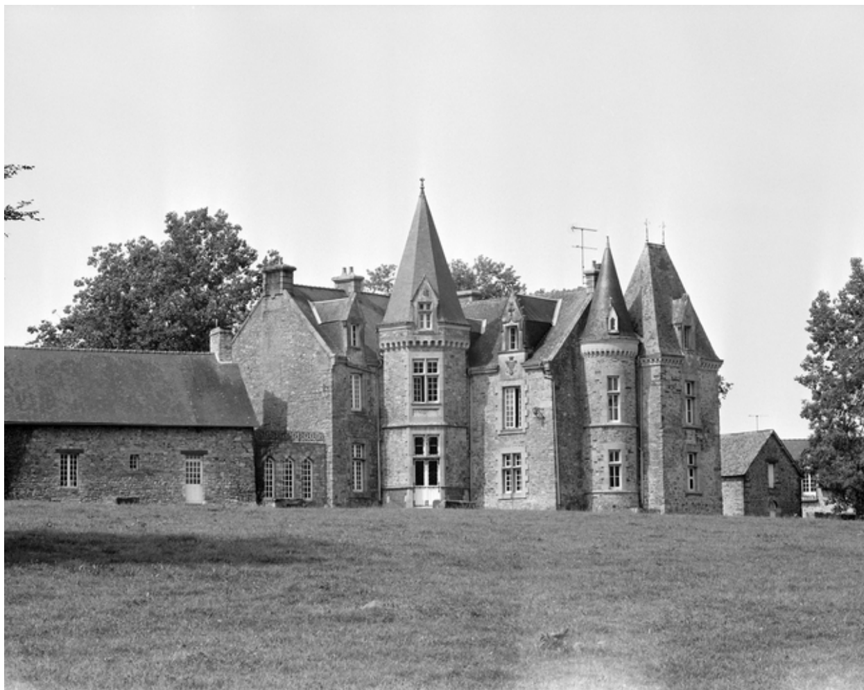
Logis, élévation nord-ouest.
