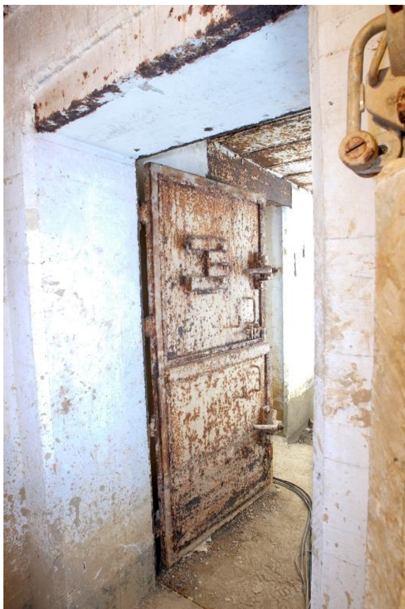
Vue du sas d'entrée, porte blindée à deux vantaux, photographie réalisée le 11 mai 2009
