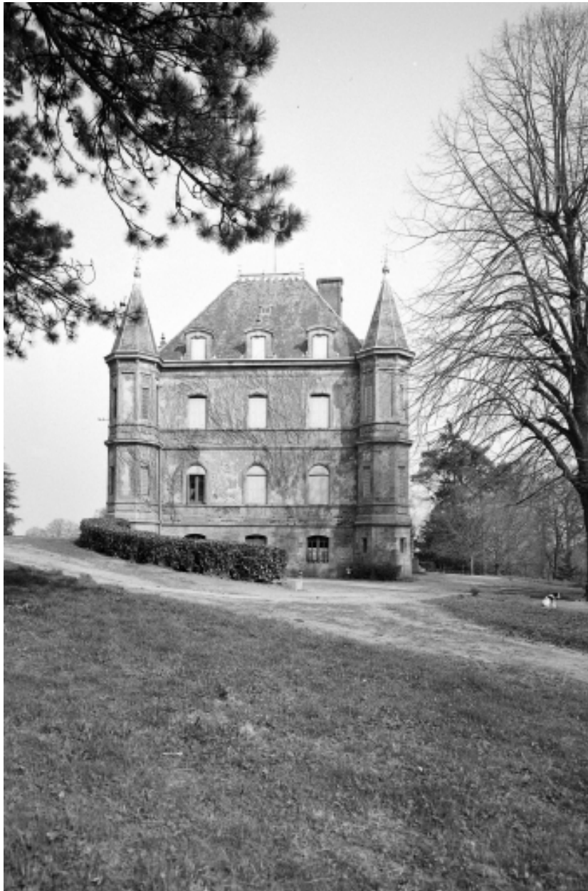
Façade ouest, vue générale.
