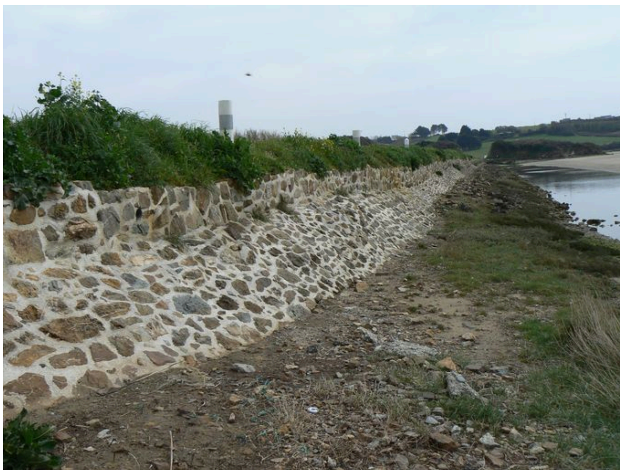
Digue-route de l'Aber côté estran
