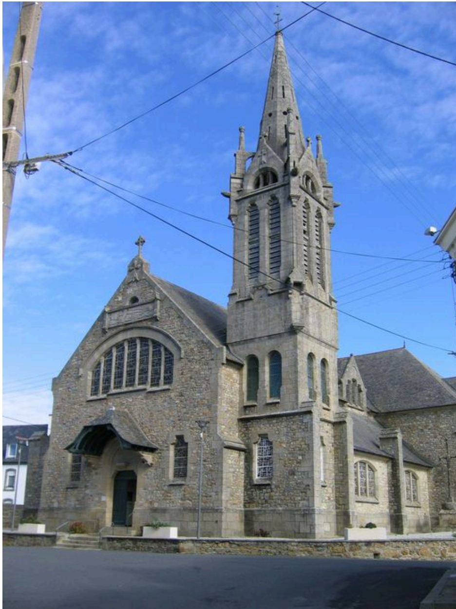
Vue générale de l'église Saint-Rémi, élévation ouest
