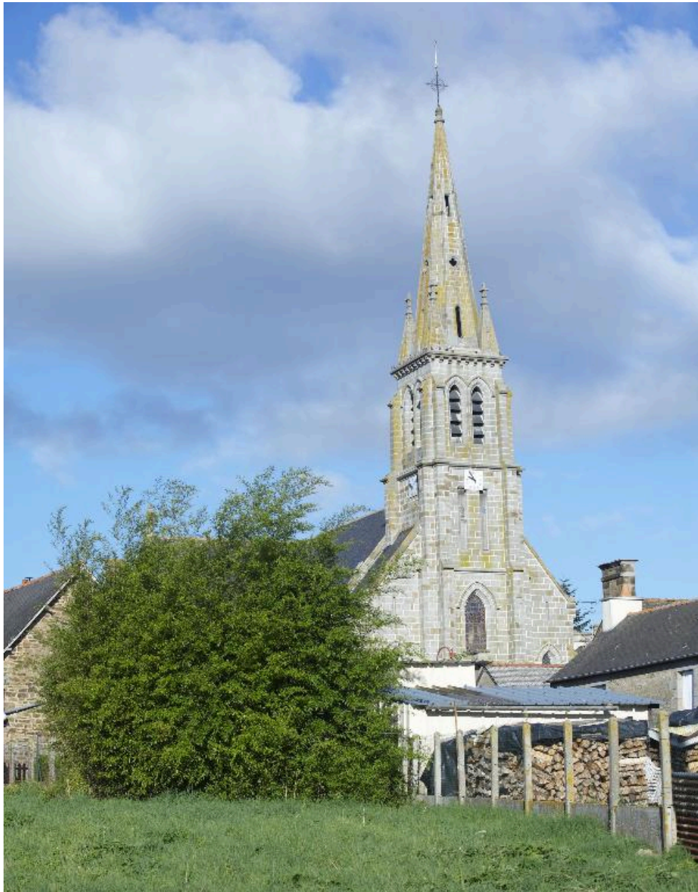
Vue générale sud-est de l'église
