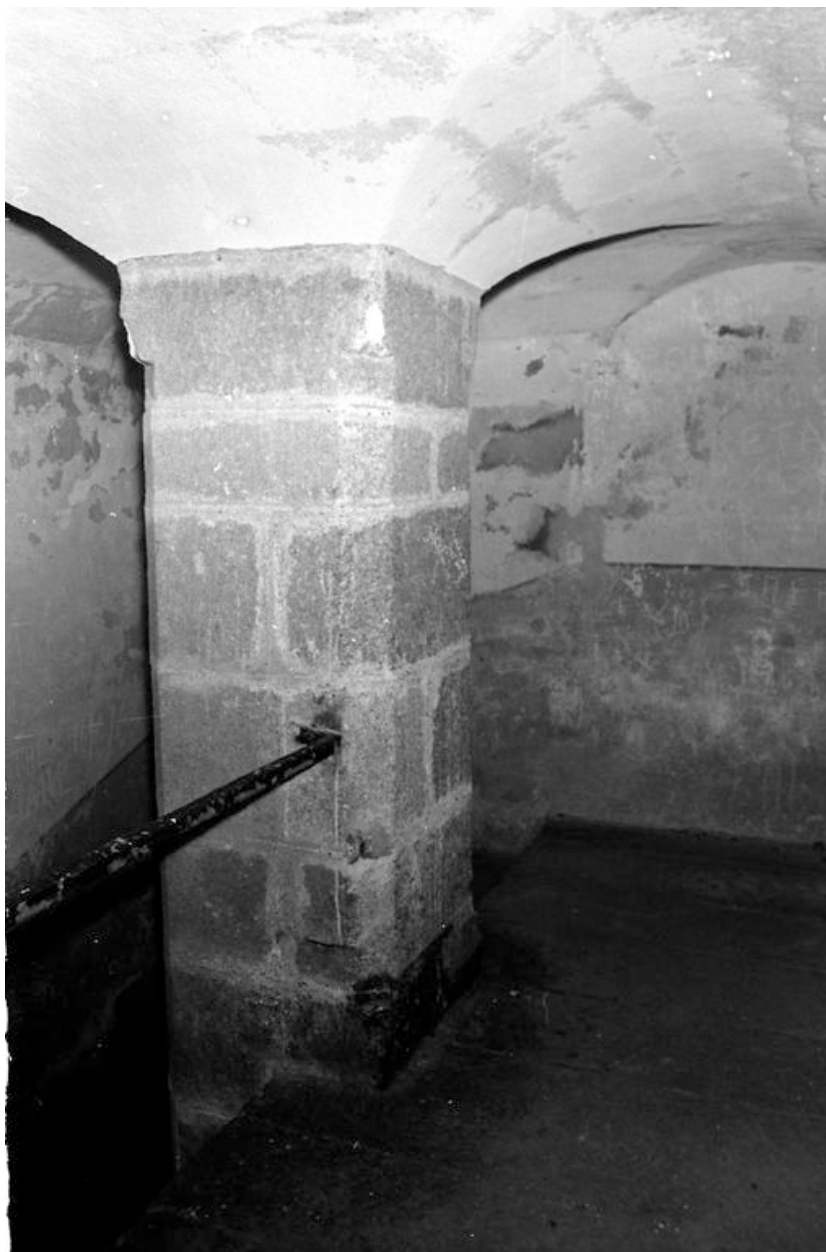
Vue du fort : cage d'escalier (état en 1969)
