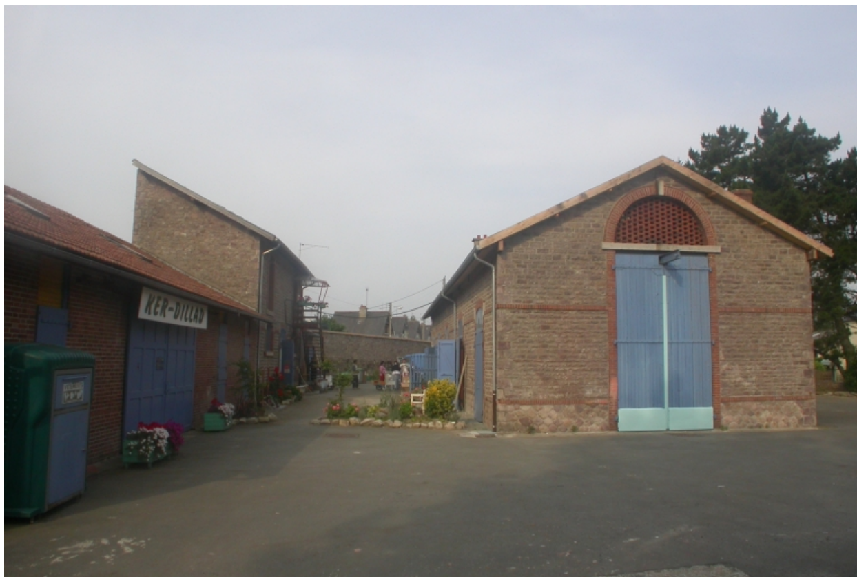
Site vu de l'est.
