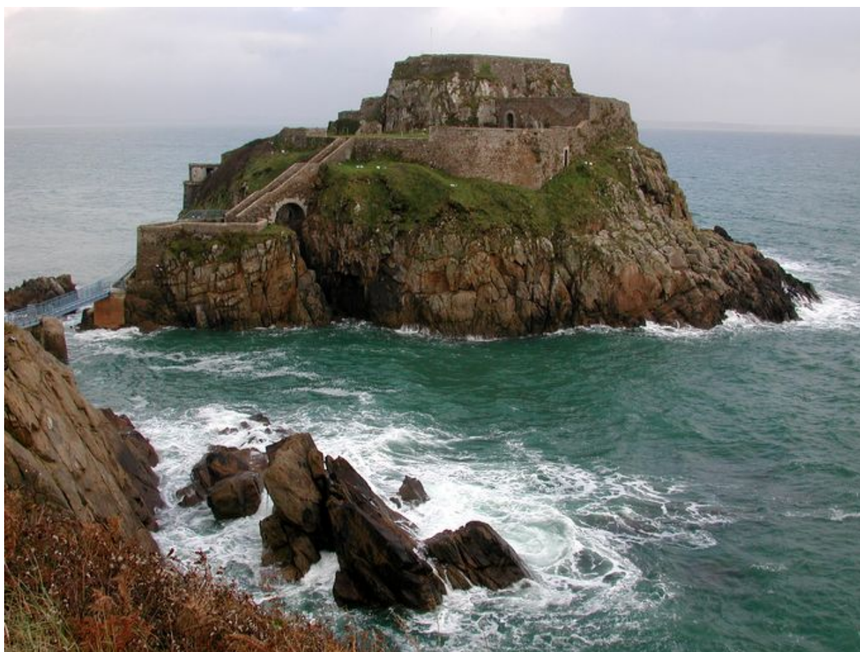
Plougonvelin : vue générale du fort dit château de Bertheaume
