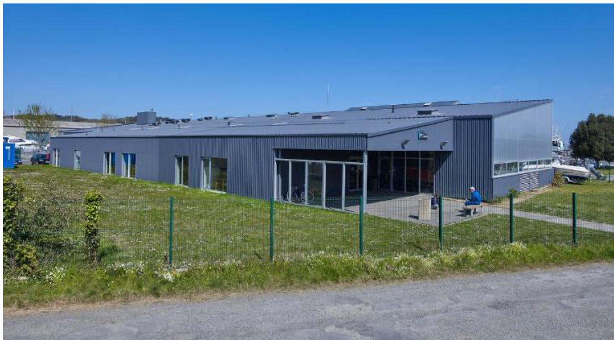
Ateliers, à Kerpallud. Vue d'ensemble prise du sud-ouest.
