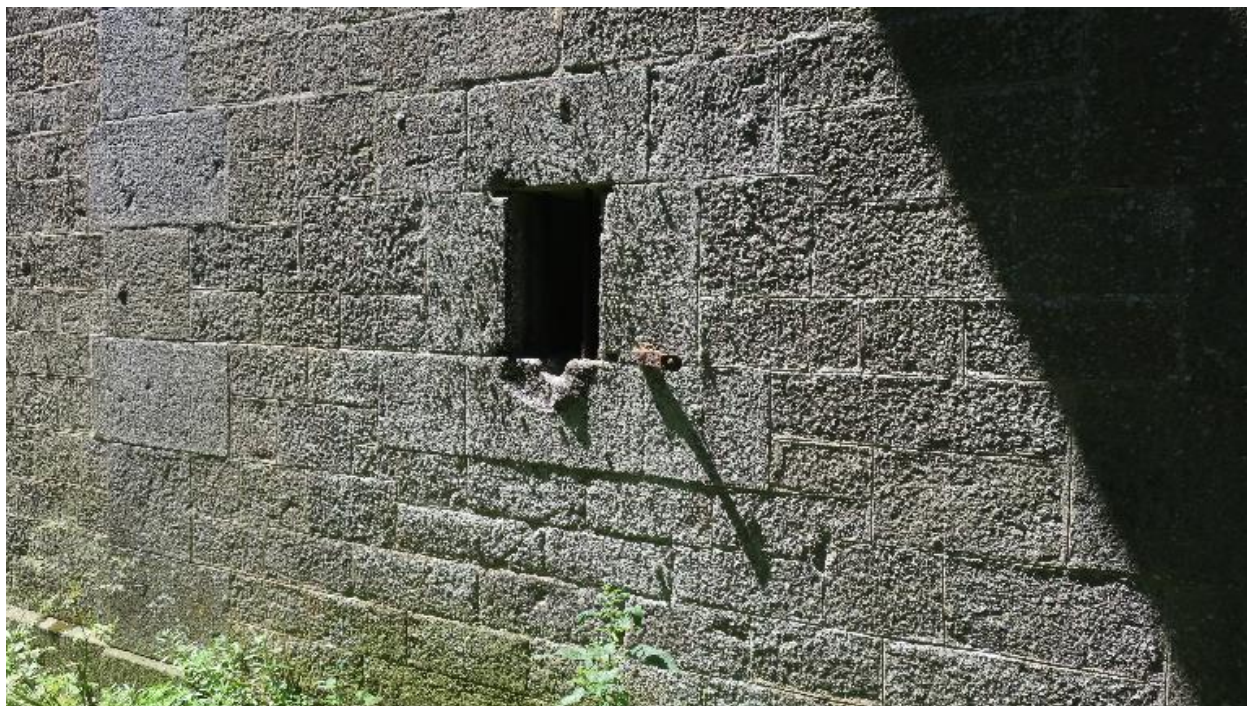
Hoedic, fort central, caserne à l'épreuve, trop-plein de la citerne.
